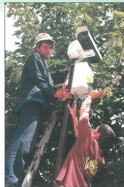
Jan Petrů ze společnosti Atoll Europe instaluje jednu z venkovních kamer. Spolu s pracovníky firmy ESCAD Trade měl na starost zajištění analogové části přenosu.
