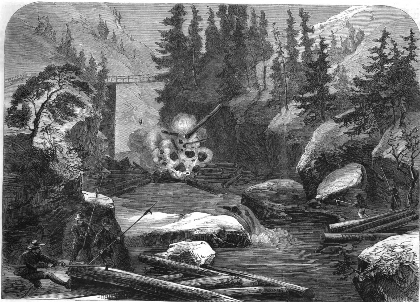
Het laten springen der steenen, die het vlotten belemmeren in de Rienz (Tirol).
