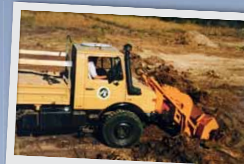
Der Airstrip entsteht.
