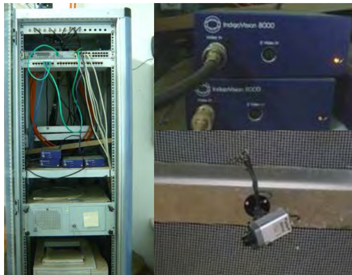
Abb. 14: Links gesamtes ©Indigo Vision System; rechts oben VideoBridge Decoder und Encoder 8000, rechts unten Kamera für die Innenanlage C an der Decke montiert
